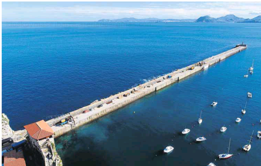
Panorámica del dique-rompeolas de Castro Urdiales. DM
